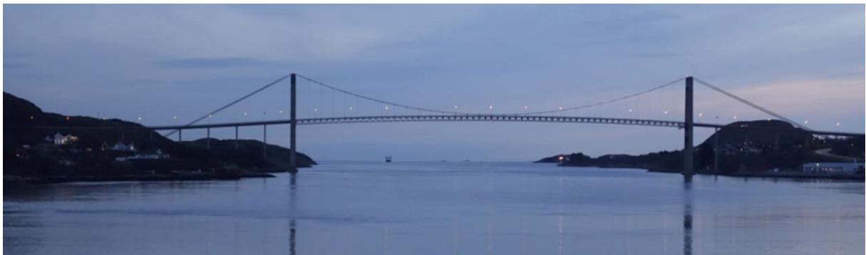
(Eine der unzähligen Fjord- und Insel-Brücken, die seit den 70er Jahren errichtet wurden)
